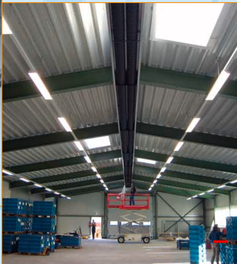
Kommissionshalle Bauform „I“
