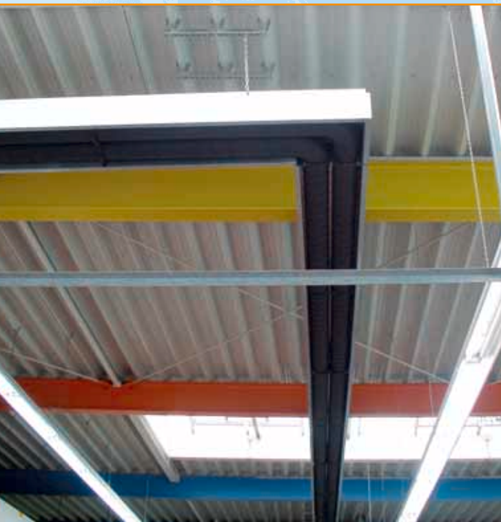
Produktionshalle Bauform „L“
